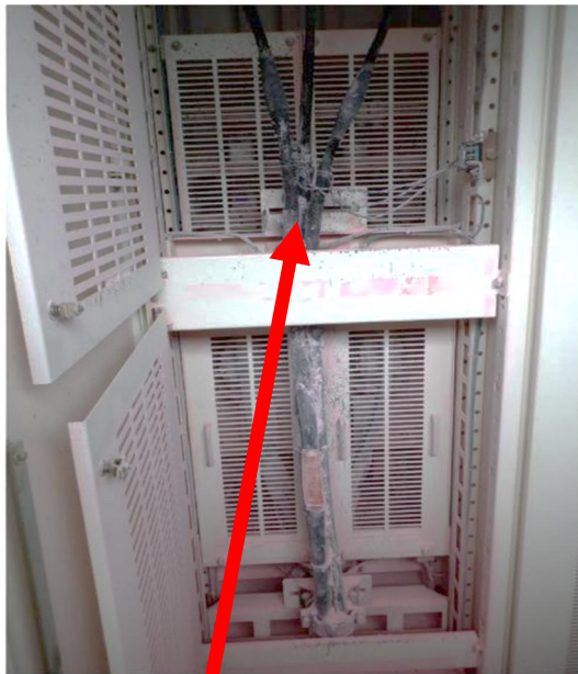
出火した高圧配電盤内ケーブル (盤背面) ピンク色の付着物は消火剤である
