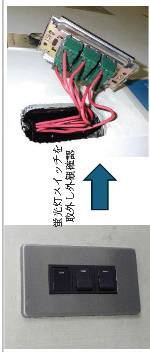
蛍光灯スイッチの外観 外観に変形、変色等の異常はなし
