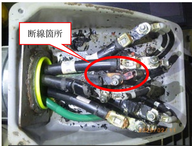
端子箱を開けて絶縁テープを除去した状態
