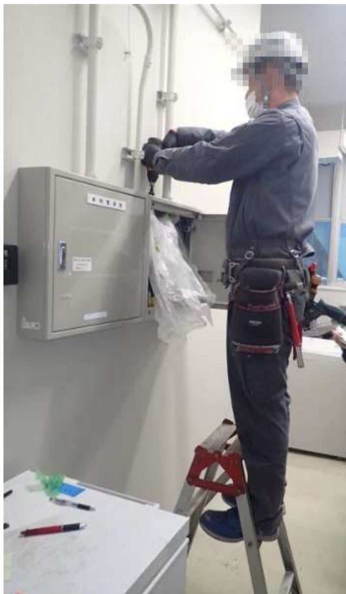
図4 分電盤内を養生シートで覆っている様子(現場検証時の再現)。
