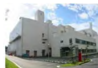
放射性廃棄物処理場(減容処理棟)
