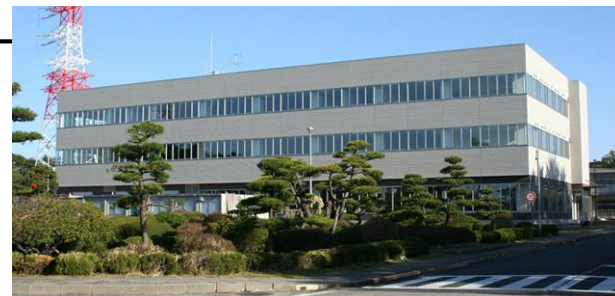
緊急時対策所
