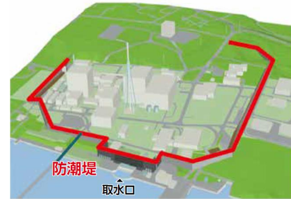
防潮堤(全長約1.7km)の設置場所
