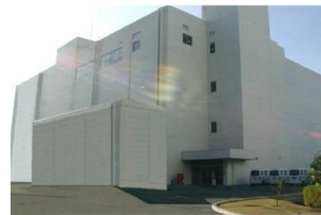
第二プルトリウム廃棄物貯蔵施設
