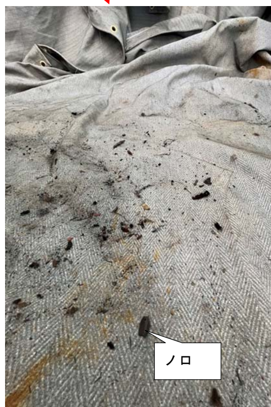
下部火気養生状況
