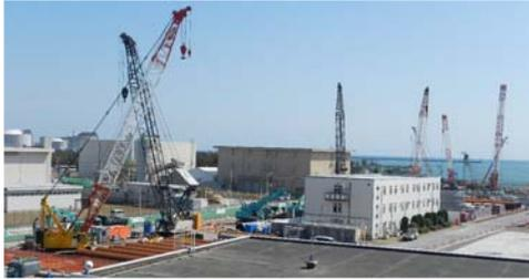
防潮堤(北側)鋼管杭設置エリア
