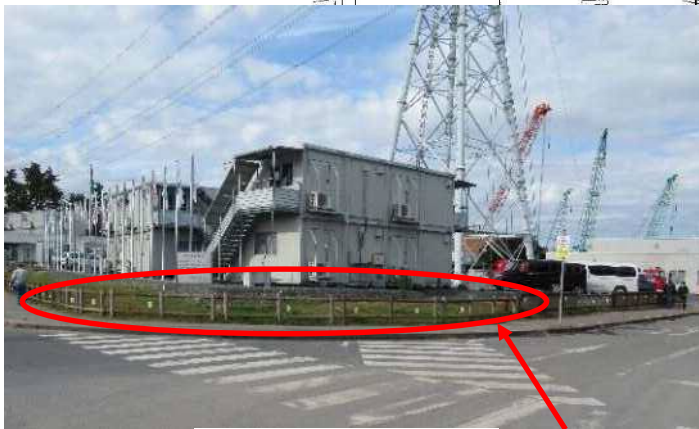
スズラン灯敷設状況写真 スズラン灯
