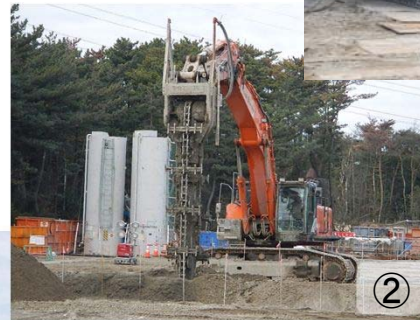
地盤改良機による表層改良 〔地表面～地下8m程度〕
