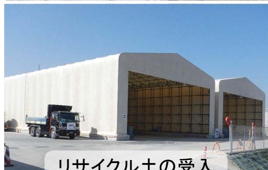
残土搬入・整地
