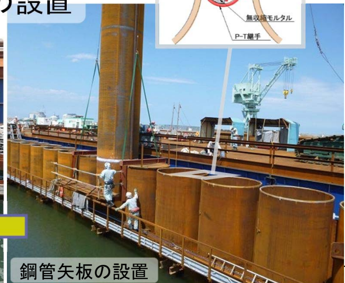
鋼管矢板継手概略構造 (矢板間水密化)
