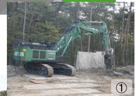
地盤改良機による表層改良 〔地表面～地下8m程度〕
