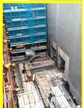
地下部配管カルバート設置
