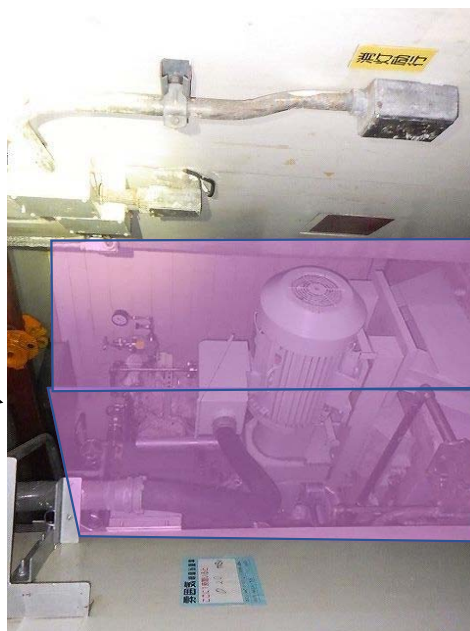
汚染拡大防止の観点からポンプ分解点検時、当該ポンプ周辺を養生
