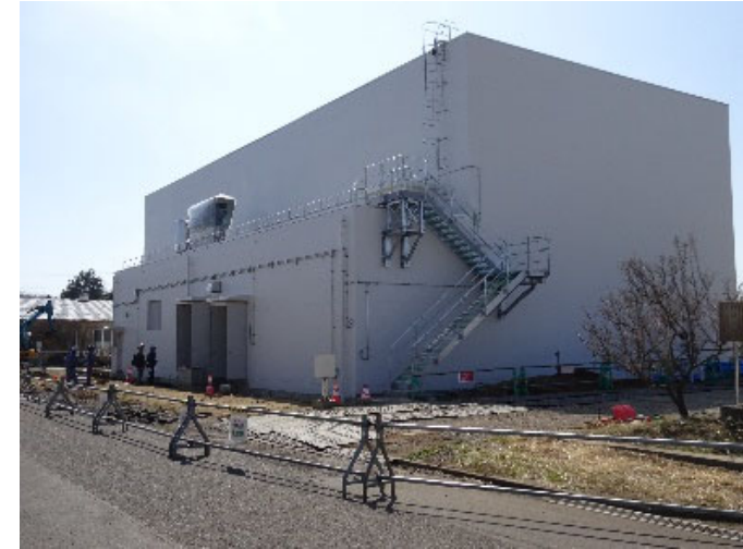
第三ウラン貯蔵庫外観(内装設備工事中)
