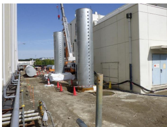
押し波用津波漂流物防護柵 工事の外観(R5.5月撮影)
