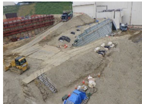
西側の状況(改良土盛土中) (R5.6月撮影)
