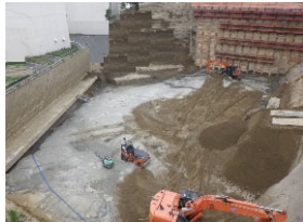
東側の状況(改良土盛土中) (R5.6月撮影)
