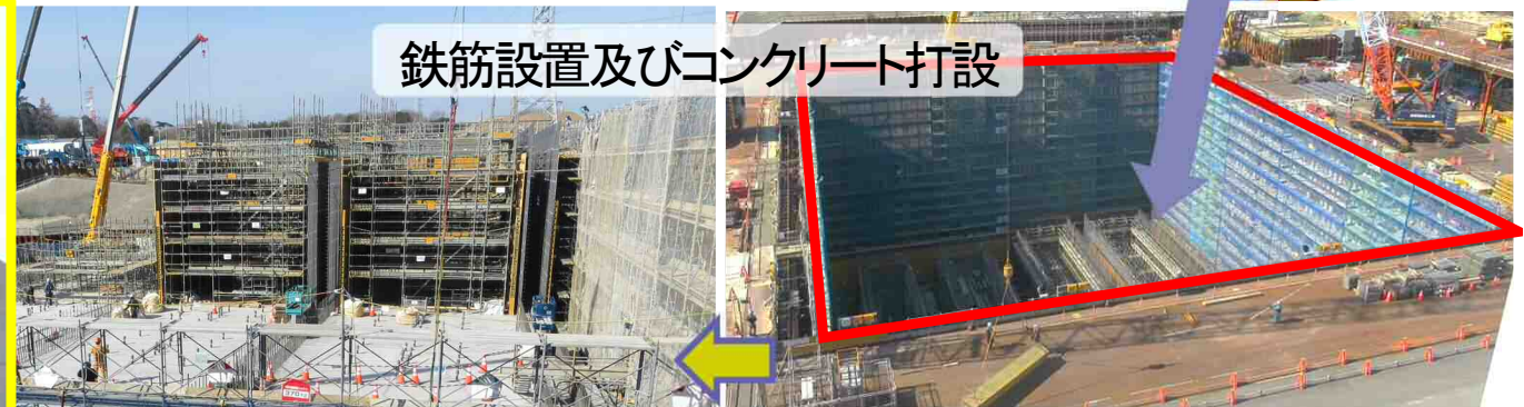
常設代替高圧電源装置置場の設置
