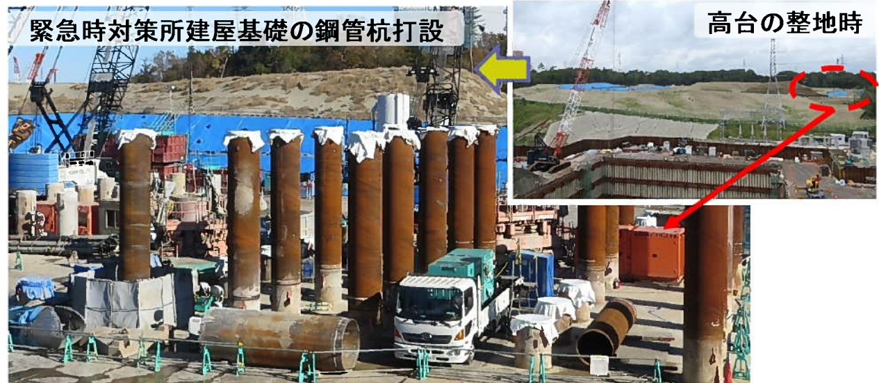
緊急時対策所建屋, 可搬型設備保管場所設置
