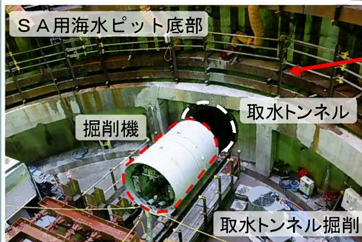
SA用海水ピット取水トンネル掘削
