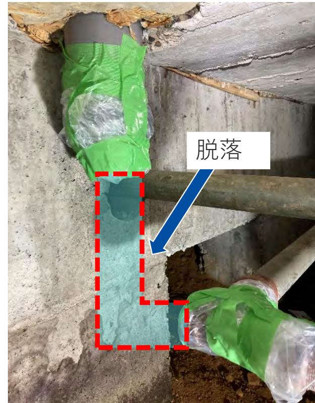
図5-3 脱落箇所Bの養生
