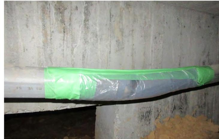
図5-1 破断箇所Aの養生
