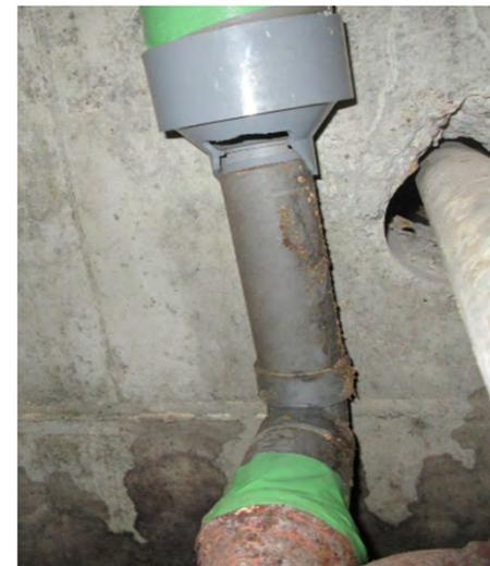
図5-2 脱落箇所Bの仮養生
