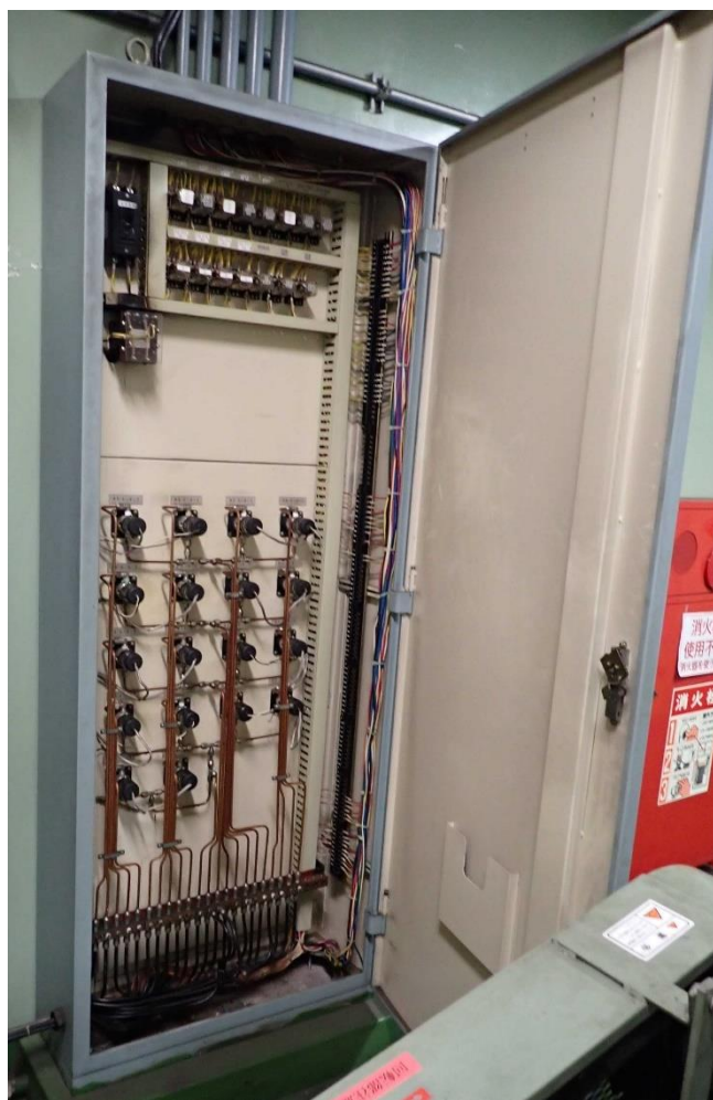
図3 計装盤 (KP-4) の外観
