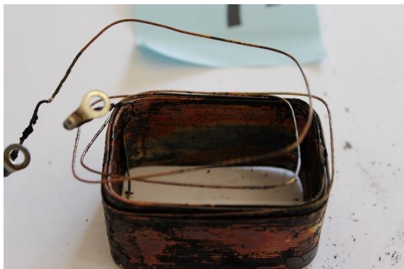
図 15 二次側巻線の状況
