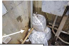
土嚢・鉄板にて養生 (応急措置)
