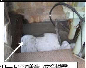
内側から土嚢・コンクリートにて養生 (応急措置)
