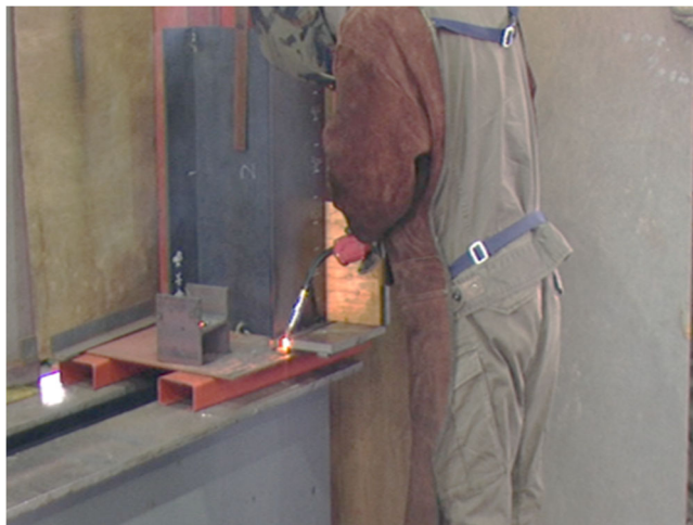
溶接箇所写真
