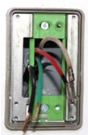
図 2 - 1 1 当該コンセントの内部配線状況
