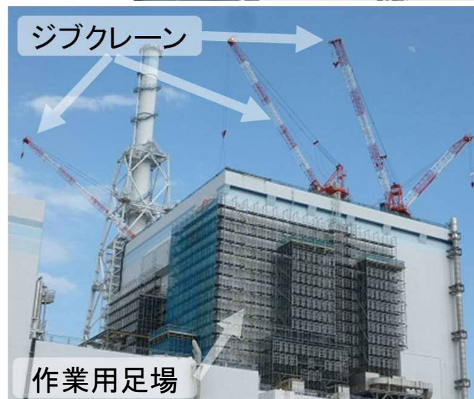
建屋周囲工事用 重機・足場の設置
