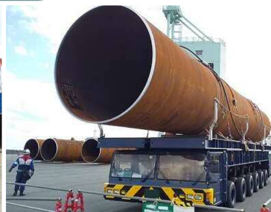
鋼管杭の搬入
