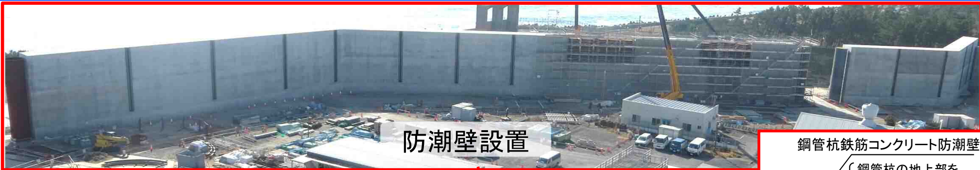
鋼管杭の地上部を鉄筋コンクリートで被覆
