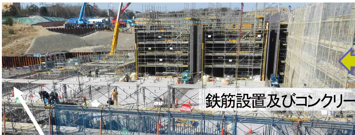
常設代替 高圧電源装置置場の設置
