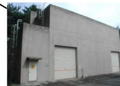
固体廃棄物一時保管棟
