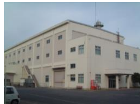
第2廃棄物処理棟
