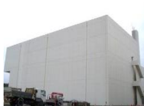
解体分別保管棟
