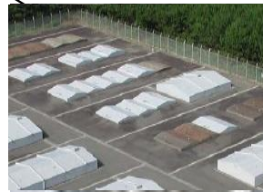
保管廃棄施設・M-1
