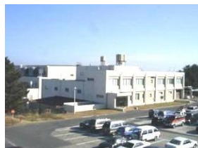
第3廃棄物処理棟
