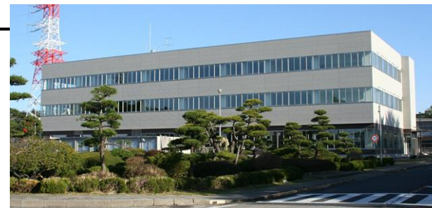
緊急時対策所
