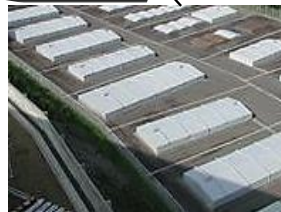
保管廃棄施設・M-2
