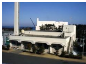
第1廃棄物処理棟
