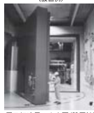
原子炉建屋の水密扉(設置済)
