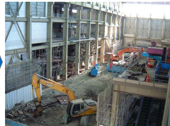
【建屋内機器撤去】
