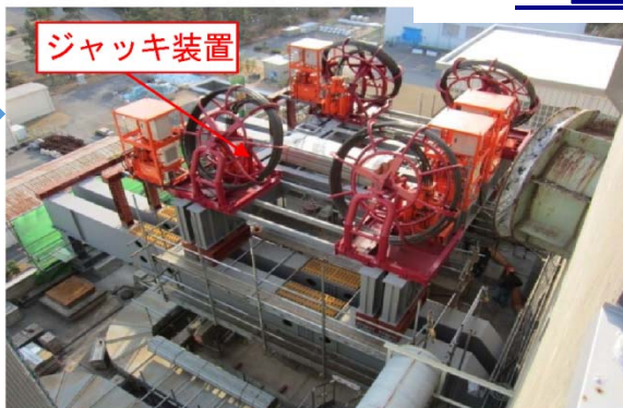
【ジャッキ装置設置】
