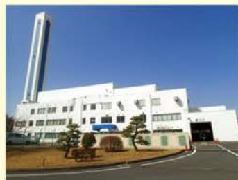
東海村 清掃センター
