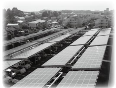
太陽光パネルの枚数は約4600枚、年間発電量は110万Kwh(約300世帯の年間の電気使用量が賄える程度)を想定しています。
