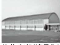
桂体育館(城里町)
