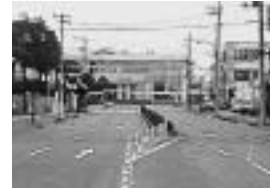
船場竹瓦線から駅西口広場方面
