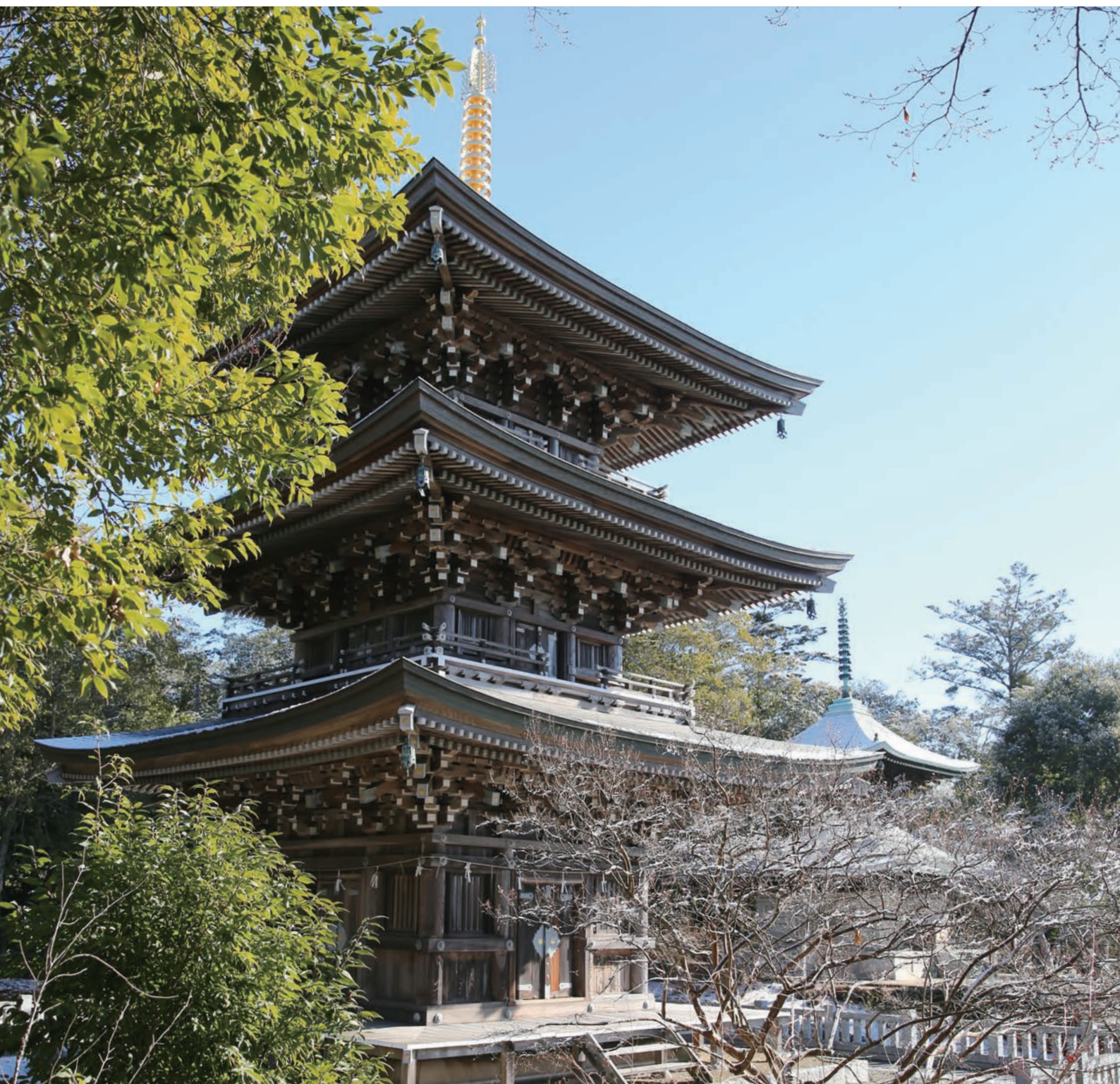
村松山虚空蔵堂(三重塔)
