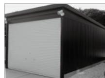
コンクリートブロックで基礎がつくられ、屋根と周壁(3方以上)を有している。
