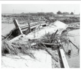
▼ 台風13号の直撃による被害(平成元年)
