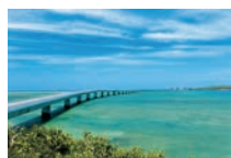
【伊良部大橋(宮古島市)】
