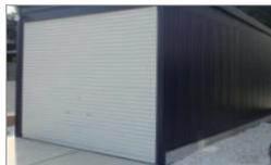
コンクリートブロックで基礎がつくられ、屋根と周壁(3方以上)を有している。
