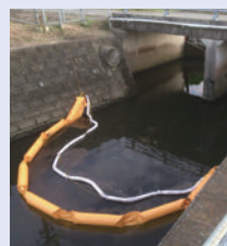
▲油の拡散を防ぐため、水路に設置されたオイルフェンス
