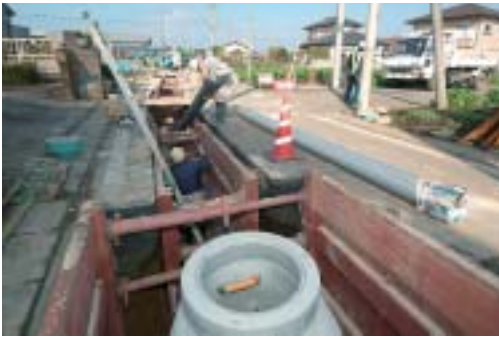
下水道整備の様子
