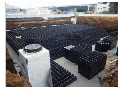
雨水貯留施設は地下に整備され、工事終了後には再び駐車場として利用できます。
