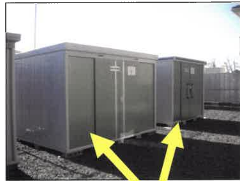
防犯・防災倉庫①②設置状況
