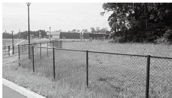
グルービー もみ 縦の木公園の新規駐車場予定地
