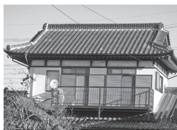
修繕後の家屋
