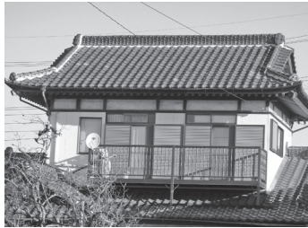
修繕後の家屋
