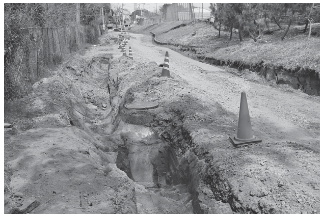
下水道本管の補修
