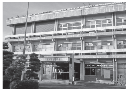
解体される合同庁舎
