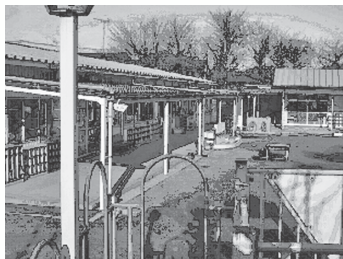
耐震補強を行う舟石川幼稚園
