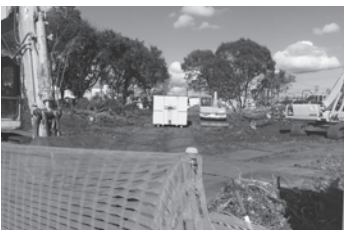
住民への説明が不十分なまま進められた交流館の造成工事
