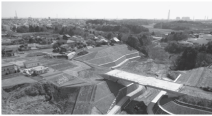
平成32年度開通予定の都市計画道路 勝木田下の内線 (東海中央区画整理地内 神楽沢橋周辺)
