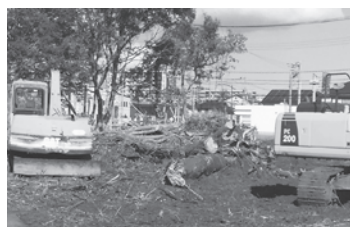
中・高校生を含む多くの住民から建設計画に疑問の声が届くが、住民への説明不十分のまま造成工事は進められている。
