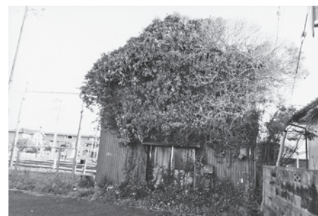
踏切近くの長期間放置された空き家
