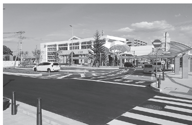
現在の東海駅西口広場
